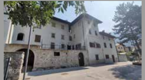
CAVEDINE centro paese, porzione di casa abitabile e indipendente, 4 piani con cortiletto, cantine, zona giorno, zona notte, mansarda al grezzo. Eventuali accessori e piazzale a parte. Euro 189.00
